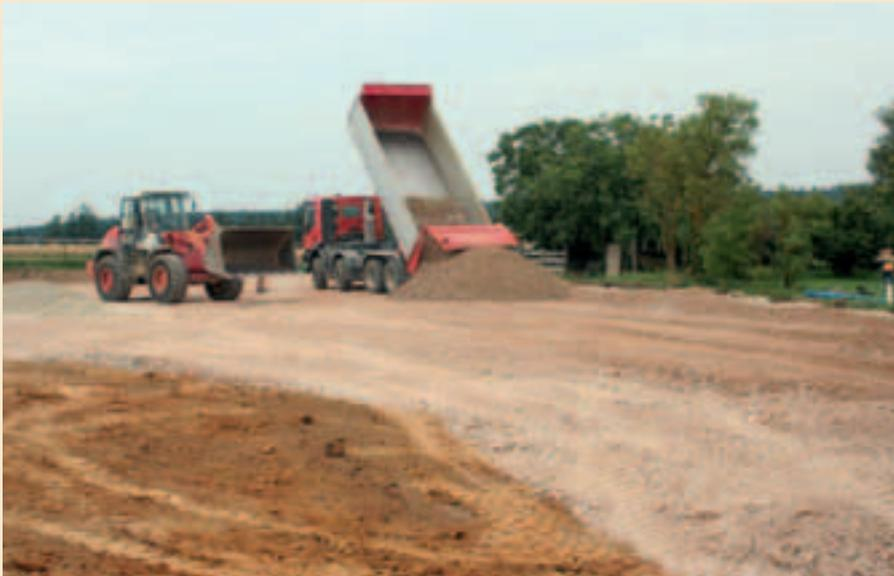
Hier wird gerade die Tragschicht aufgebracht.
