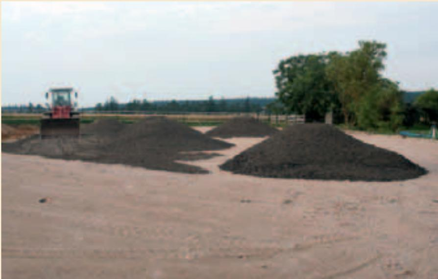
Über die Tragschicht kommt die Trennschicht.
