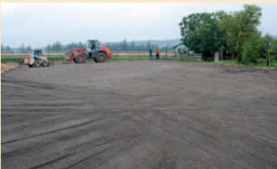
So sieht eine fertige Trennschicht aus.
